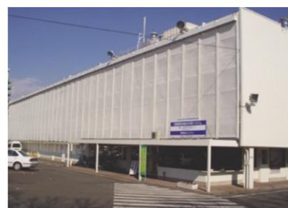
光触媒による更衣棟冷却システム
