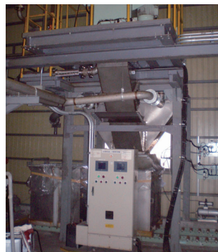
塗料汚泥回収設備
