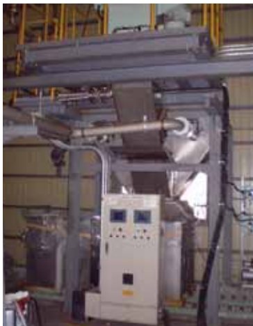
塗料汚泥回収設備
