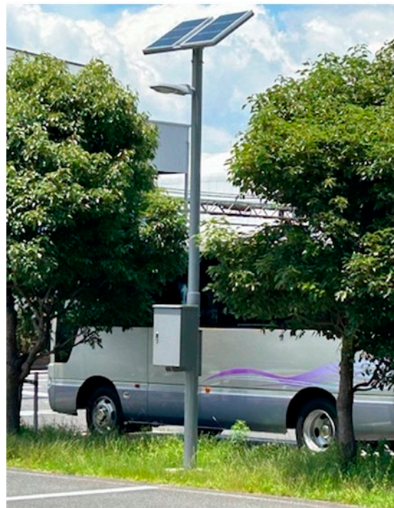
太陽光パネルリチウムイオン電池蓄電型外灯設置
