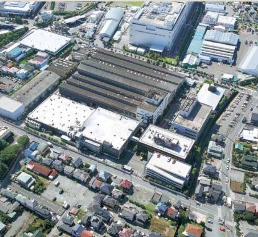
テクノセンター 設計、試作車の製作などを行う当社「開発」部門の中心であり、生産設備を設計・製作する「工機」部門の拠点でもあります。
