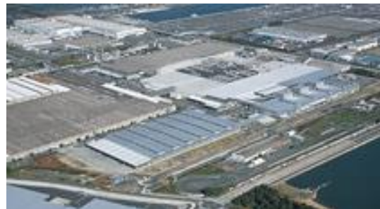
日産車体九州工場
