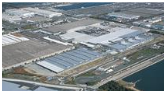
日産車体九州工場
