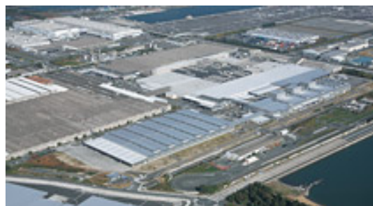
日産車体九州工場
