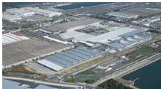
日産車体九州工場
