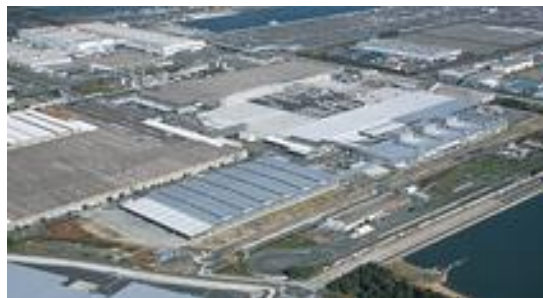
日産車体九州工場
