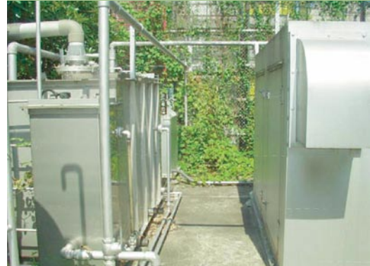
第3地区土壌地下水浄化プラント
