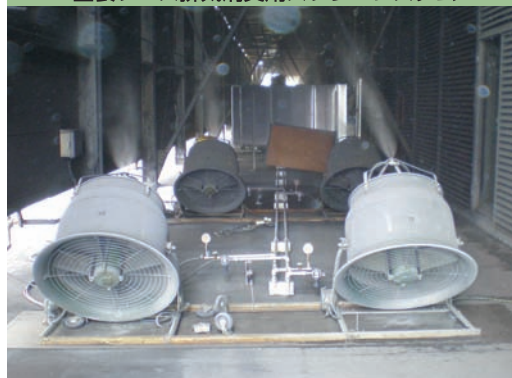
塗装ブース排気消臭剤スプレーシステム
