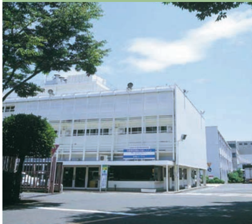
光触媒を利用したビル冷却システム
