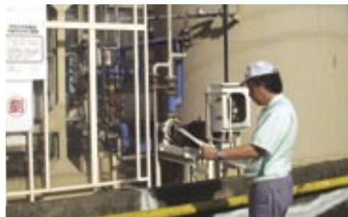
設備点検の様子
