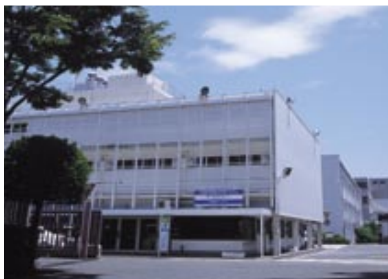
光触媒ビル冷却システムを利用した更衣棟
