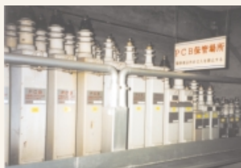
PCBの保管状況
